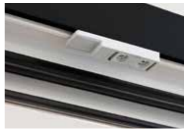
CONTACT D'OUVERTURE
